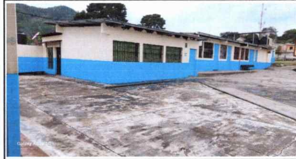
Foto 12: Área de sustitución de línea principal de agua potable.
