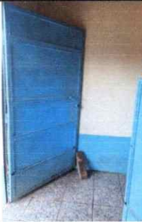
Foto 11: Cambio de dirección de puerta para inatallación de lavamanos.
